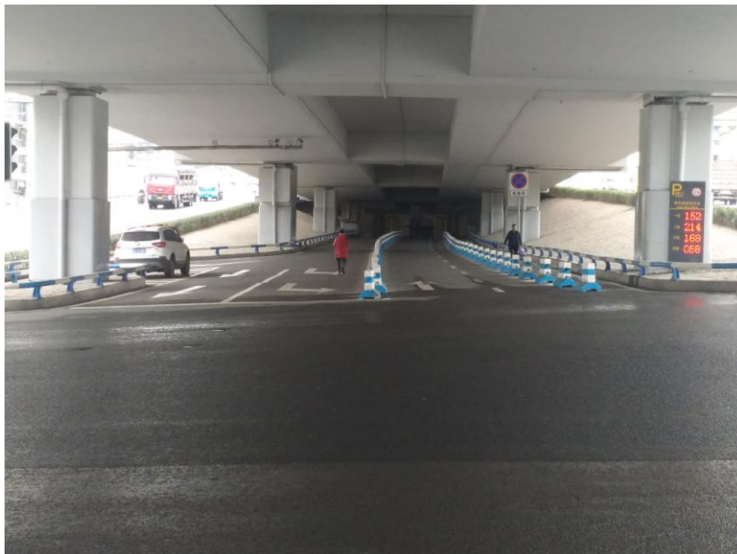
图 2.1 桥下车库连接道
