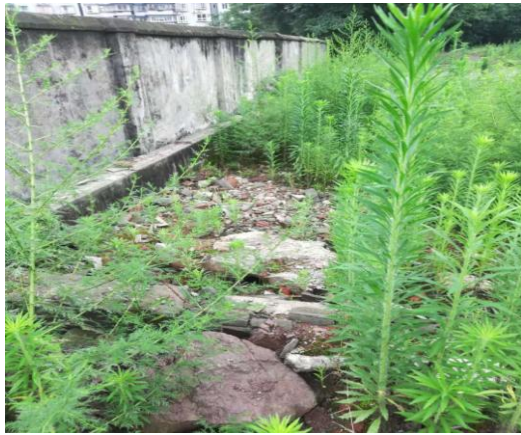
丰和涂装公司原废水处理池
