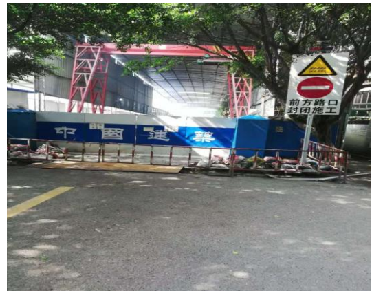
轨道九号线临时施工场地
