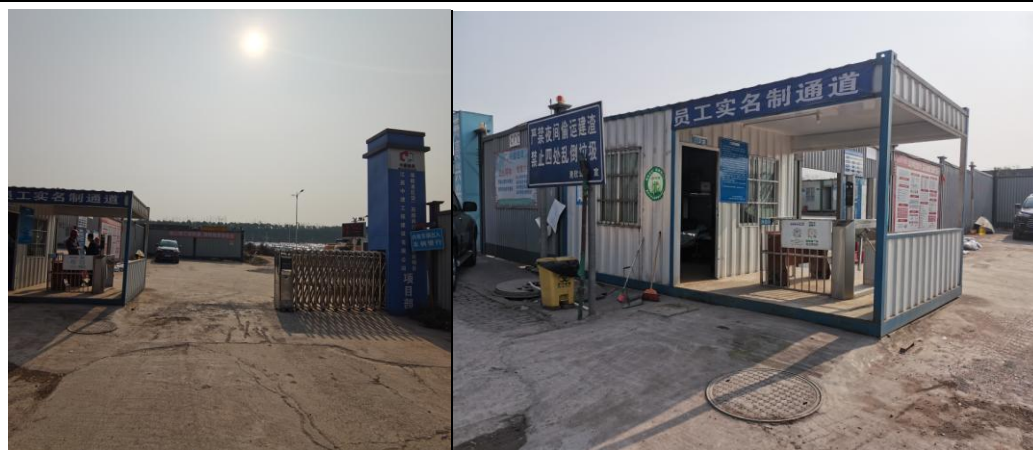
临时占地实景
