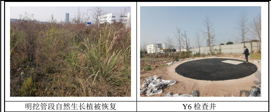
图 4.1 明挖段 Y2 至 Y6 段生态恢复现状
